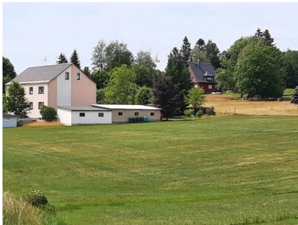
Abb. 4: Mehrfamilienhausbebauung, im Hintergrund einzelstehendes Einfamilienhaus Rißbrücker Weg 14
